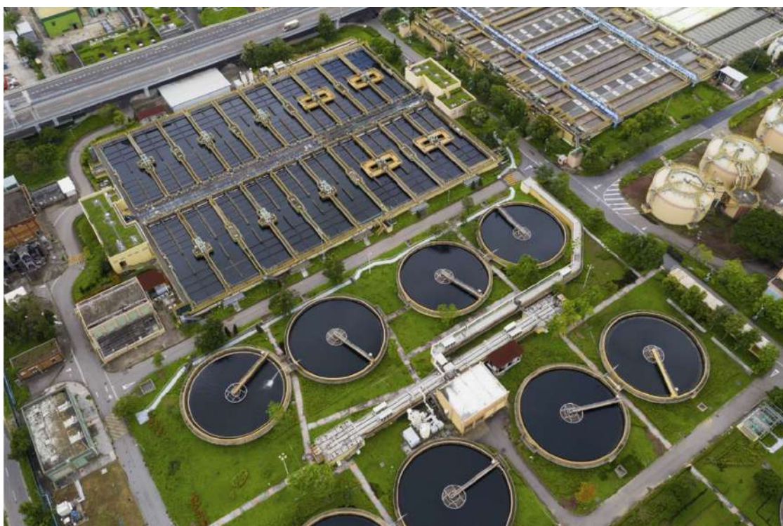
El Ministerio de Vivienda, Construcción y Saneamiento suscribió el contrato vía APP para la construcción de la nueva Planta de Tratamiento de Aguas Residuales en Chincha. (Fuente: Proinversión)
